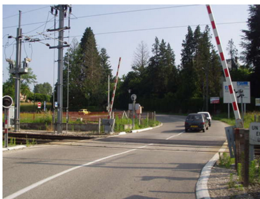
Figure 3 : PN muni d'une SAL avec barrières
